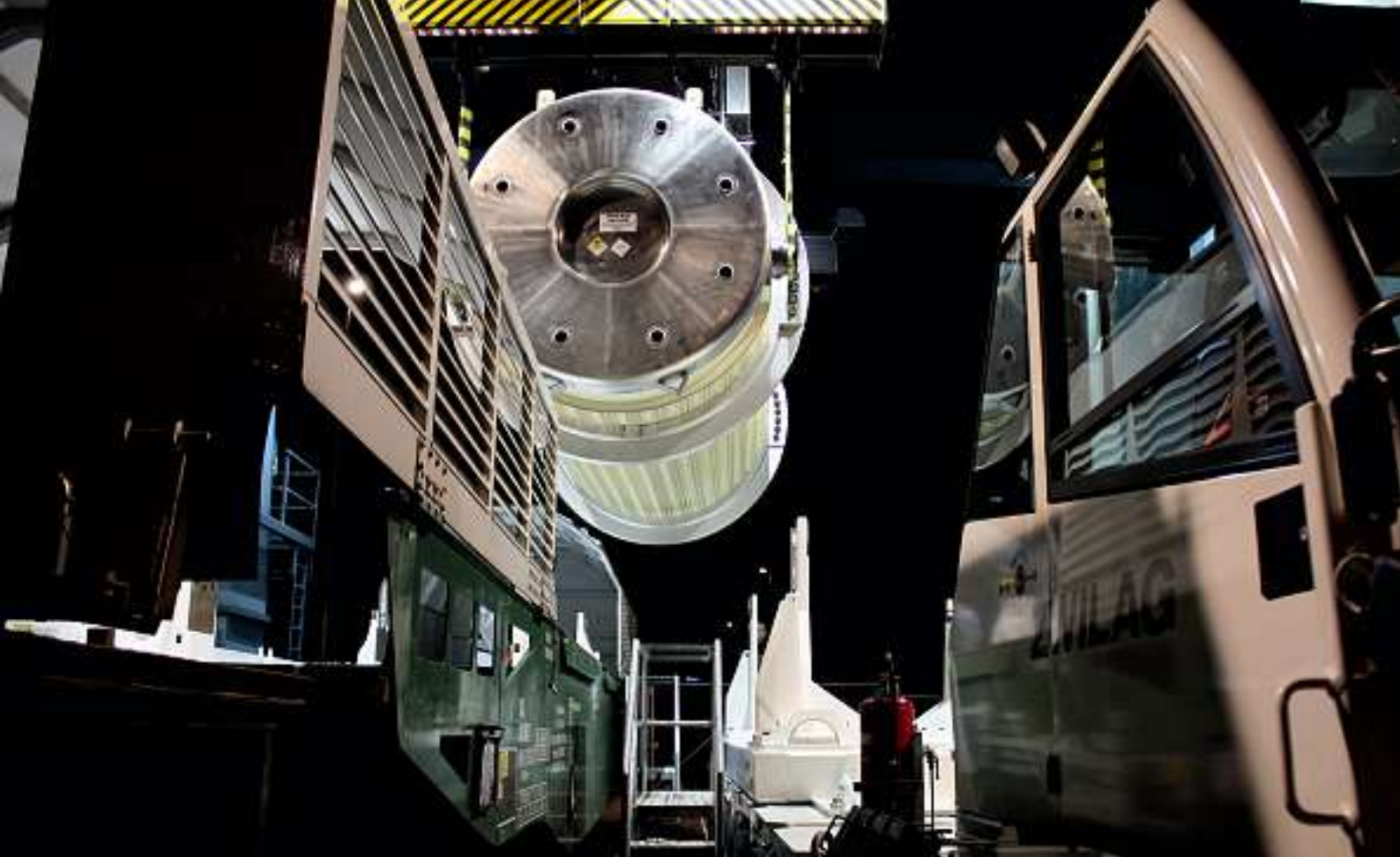
Bild: Behälter wird bei der Umladestation des Zwiilag von einem Bahnwagen auf das Schwerlastfahrzeug umgeladen (Zwiilag)
