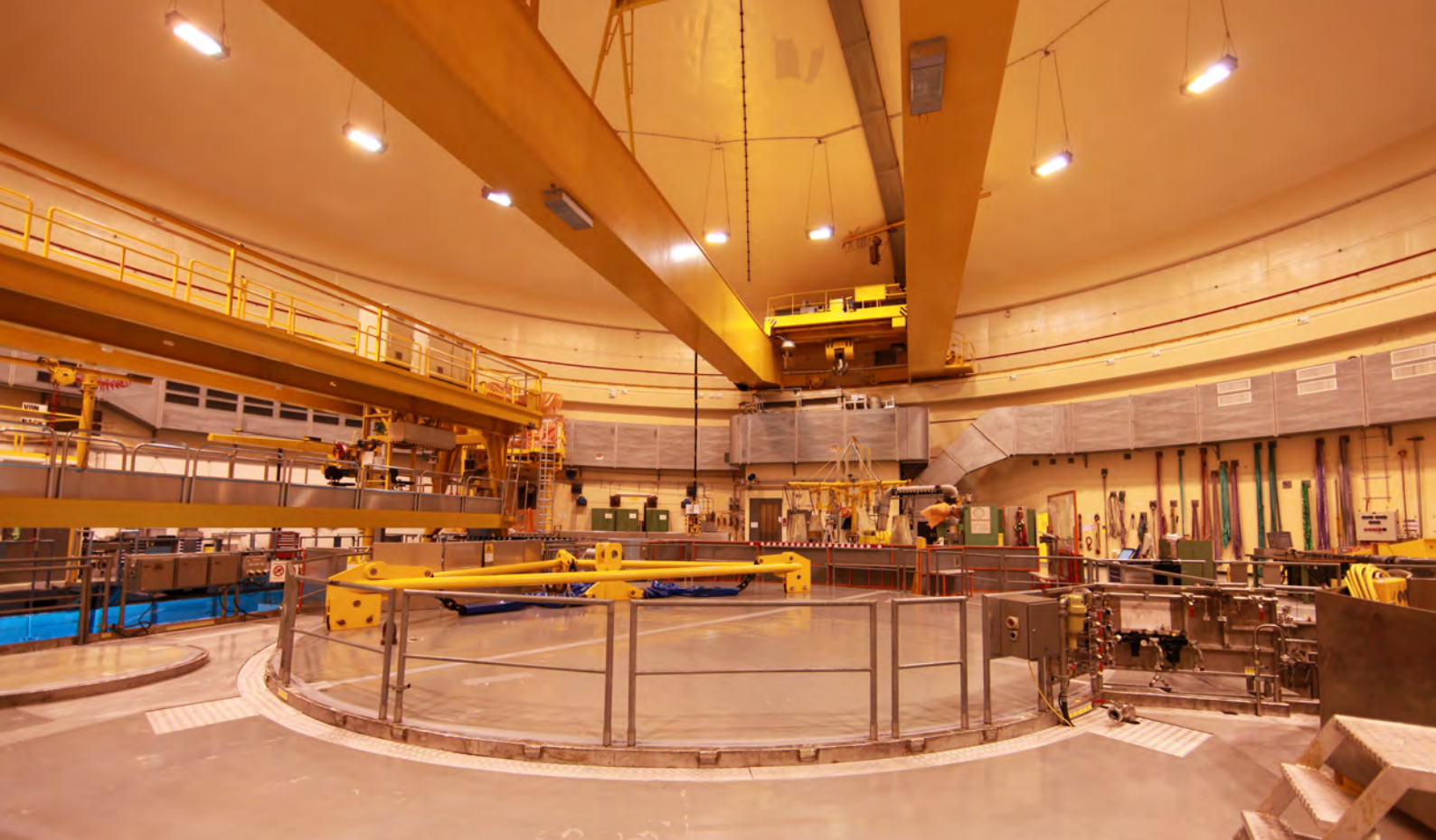
Bild: Reaktorgebäude KKM (KKM)
