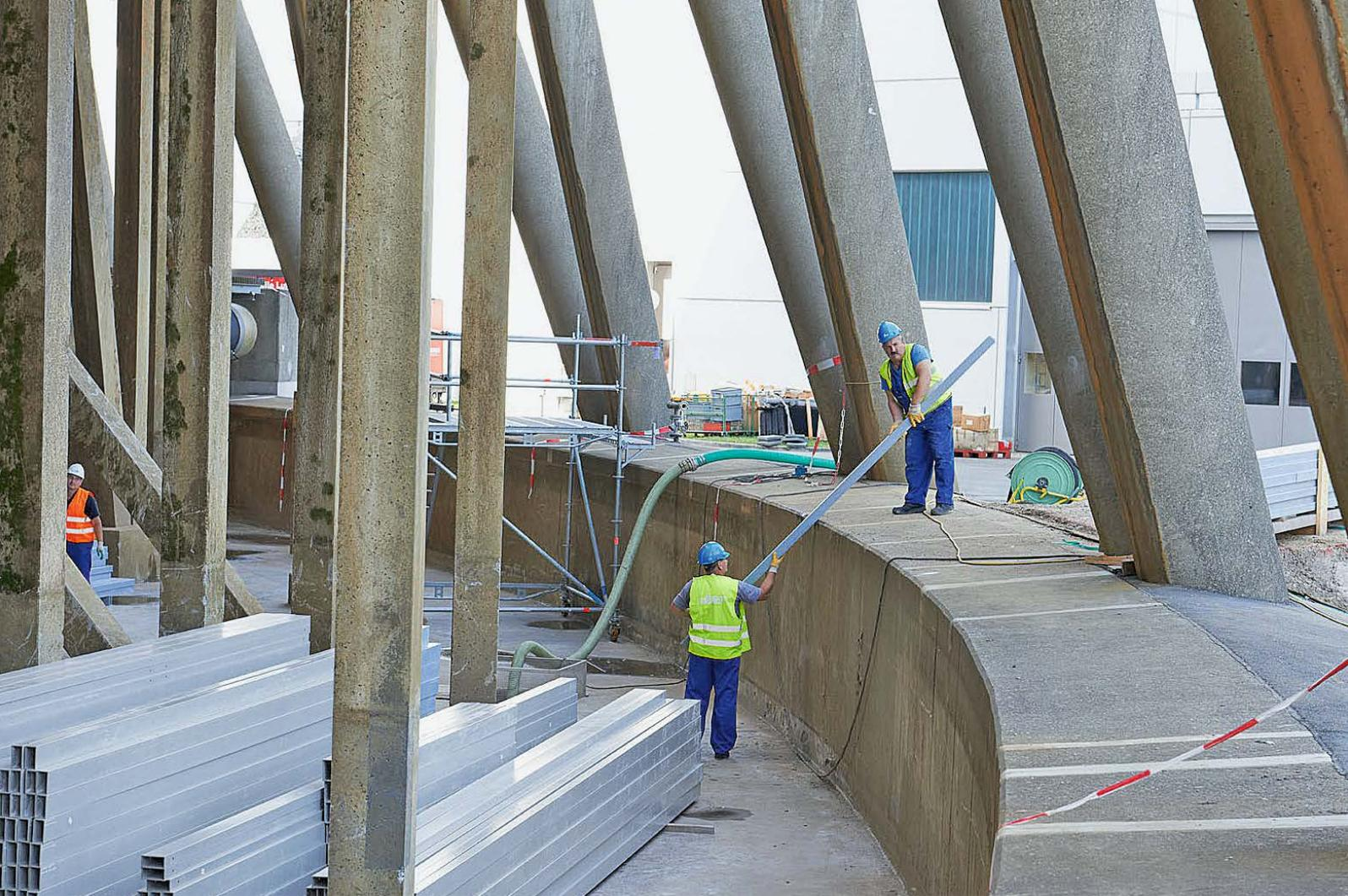
Kühlturm Kernkraftwerk Leibstadt: Erneuerung der Rieselplatten in 2012 (Bild: KKL)
