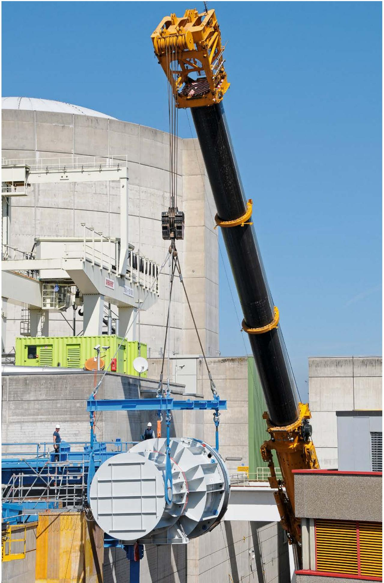
*Transport d'un des couvercles de cuve de réacteur à Beznau (Image : centrale nucléaire de Beznau)*
