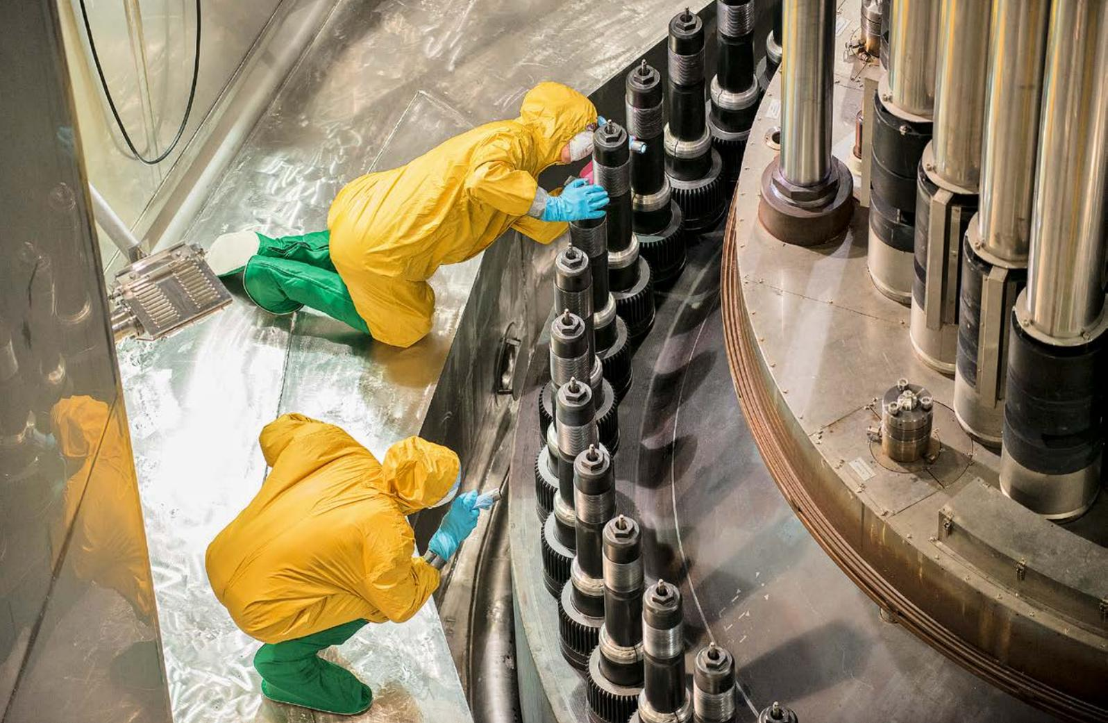
Contrôle visuel au couvercle de la cuve du réacteur (Image : centrale nucléaire de Gösgen)
